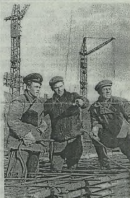
Бригада электросварщиков завода строительных материалов на строительстве корпуса фабрики обогащения Слева направо: Валентин Гречишников Анатолий Иванов, Александр Топоров
